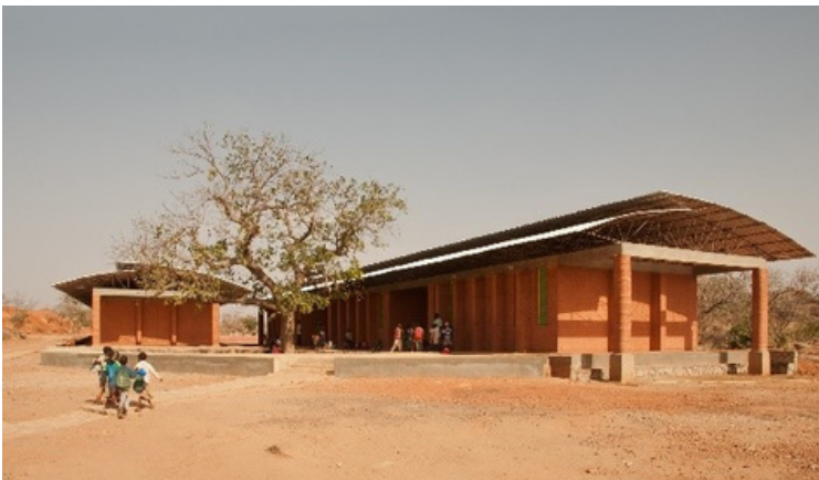
Sur-toiture d'un bâtiment scolaire
