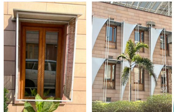
protections solaires des ouvertures
