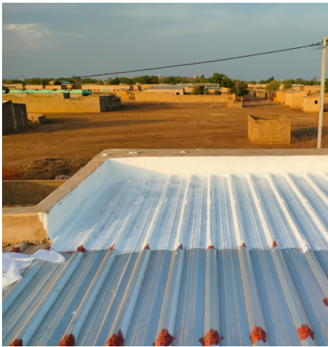
Mise en oeuvre de cool roof
