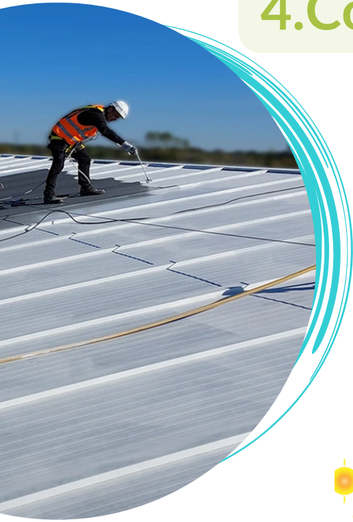
Application d'une peinture cool roof sur une toiture
