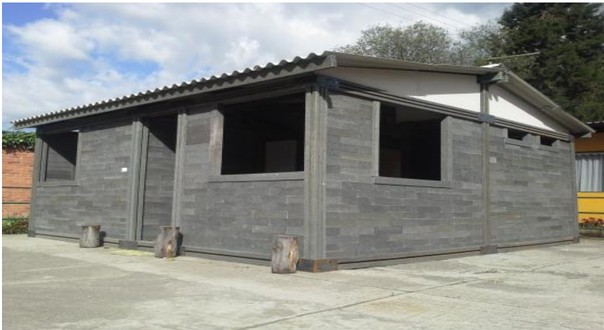
Logement en plastique recyclé fabriqué par l'entreprise colombienne Conceptos Plasticos
