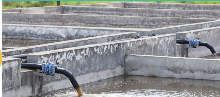
ໂຮງງານບໍາບັດຂີ້ຕະເລດອາຈົມ ຢູ່ ນະຄອນປາກເຊ ທີ່ມີຂີດຄວາມສາມາດໃນການຮອງຮັບຂີ້ຕະເລດອາຈົມ 25 ແມັດກ້ອນ/ວັນ. © GGGI Lao PDR
